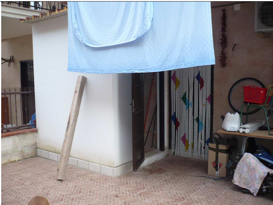
Foto 22: idem altra angolazione con particolare ripostiglio abusivo
