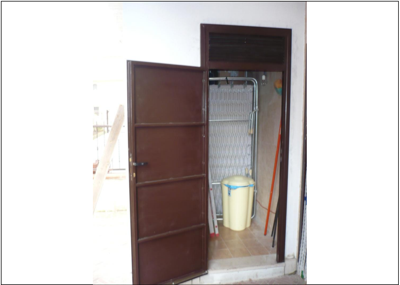
Foto 23: ingresso ripostiglio abusivo
